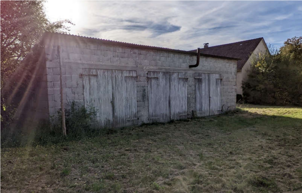
Abbildung 3: Garage im künftigen Baufeld, 5.10.2022
