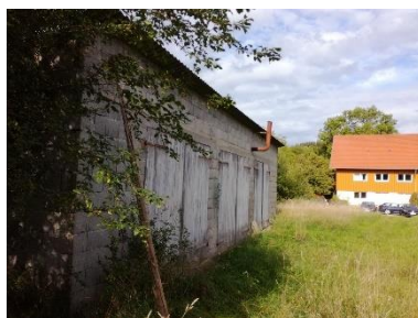
Abb. 3 Plangebiet Blick nach Nordwesten
